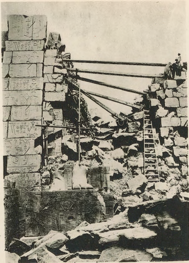
1. — Xe pylône. La pile S.-E. vient d'être redressée, 15 avril 1923.
